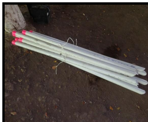
Figura 14: Tubos PVC para la delimitación de las PPM
