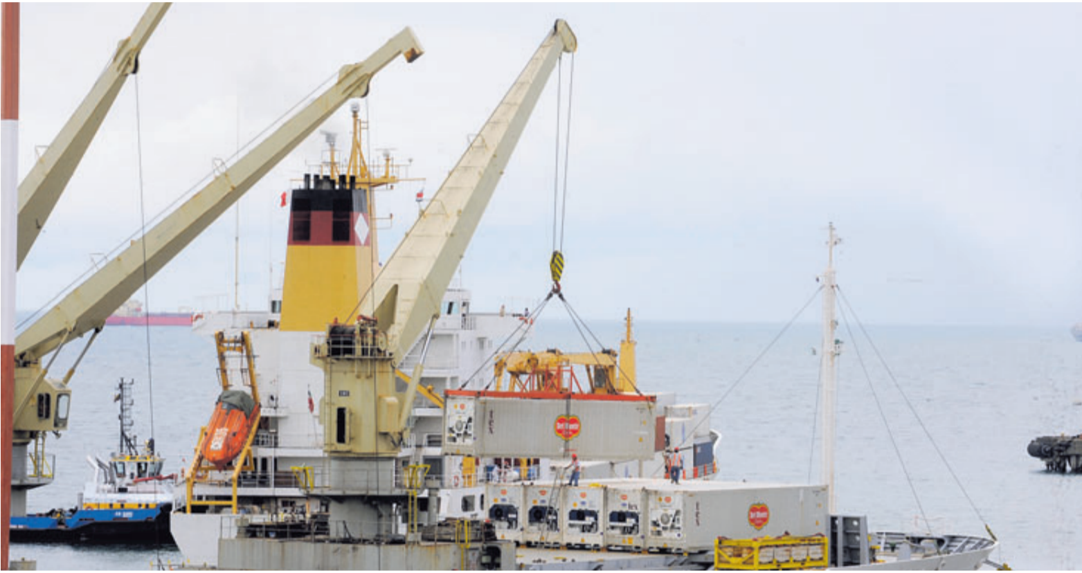
Puerto Moín es la principal ventana comercial del país en la actualidad. Ahí opera el puerto de Japdeva y se construye la terminal de contenedores, que empezará a operar en enero de 2018. El plan del canal seco contempla la construcción de otra terminal en Parismina. JONATHAN JIMÉNEZ
