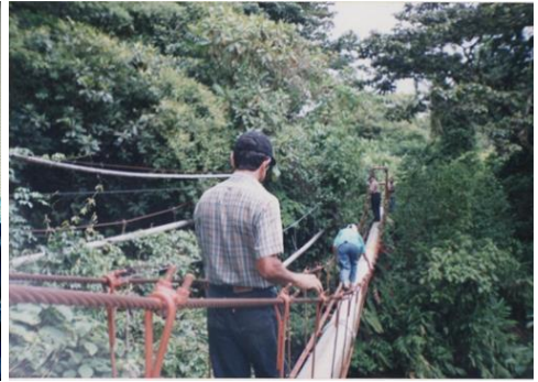
Nueva tubería de la ASADA.
