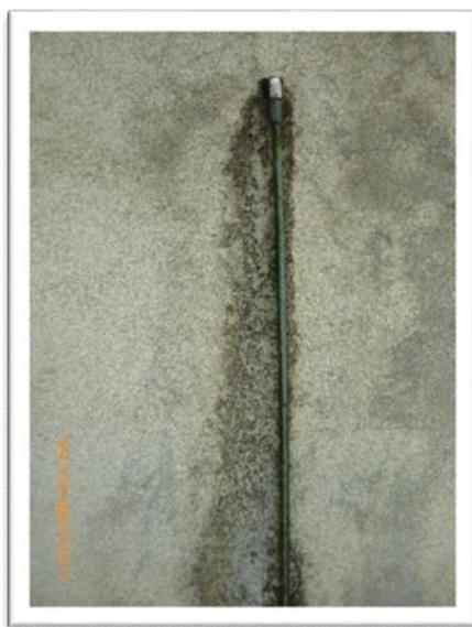
Fotografía 106. Fuga en una de las tuberías de entrada en la casa de funcionarios del sector Santa María © ACEPESA
