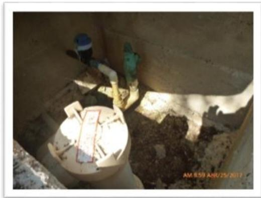
Fotografía 15. Tanque de almacenamiento de agua con clorador en el sector Junquillal © ACEPESA
