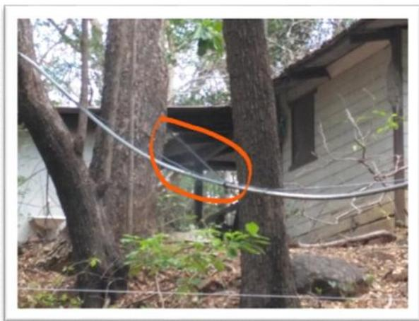
Fotografía 26. Tubería de agua para consumo con fuga en el sector Murciélagu © ACEPESA
