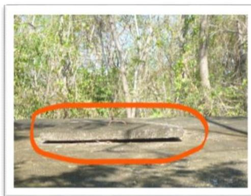
Fotografía 14. Tapa del tanque de almacenamiento con abertura en el sector Junquillal © ACEPESA
