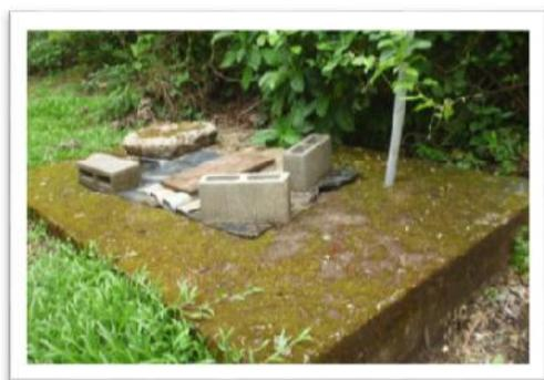
Fotografía 127. Tanque séptico de la casa de funcionarios del sector Pailas © ACEPESA
