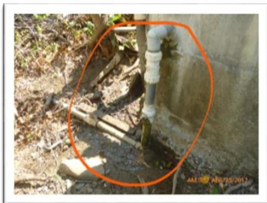
Fotografía 13. Tanque de almacenamiento de agua con fugas en el sector Junquillal © ACEPESA
