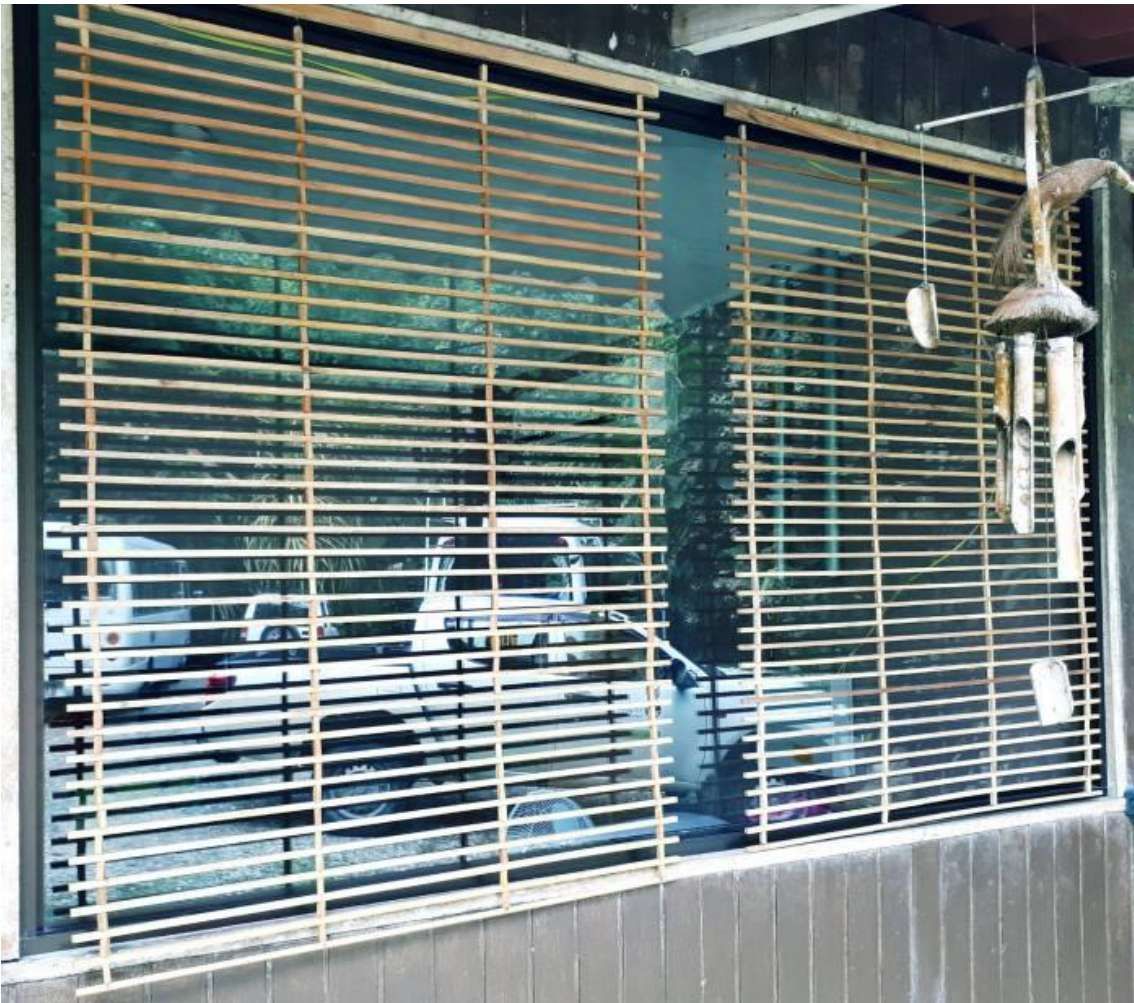
Esta es una vista desde el interior del edificio
